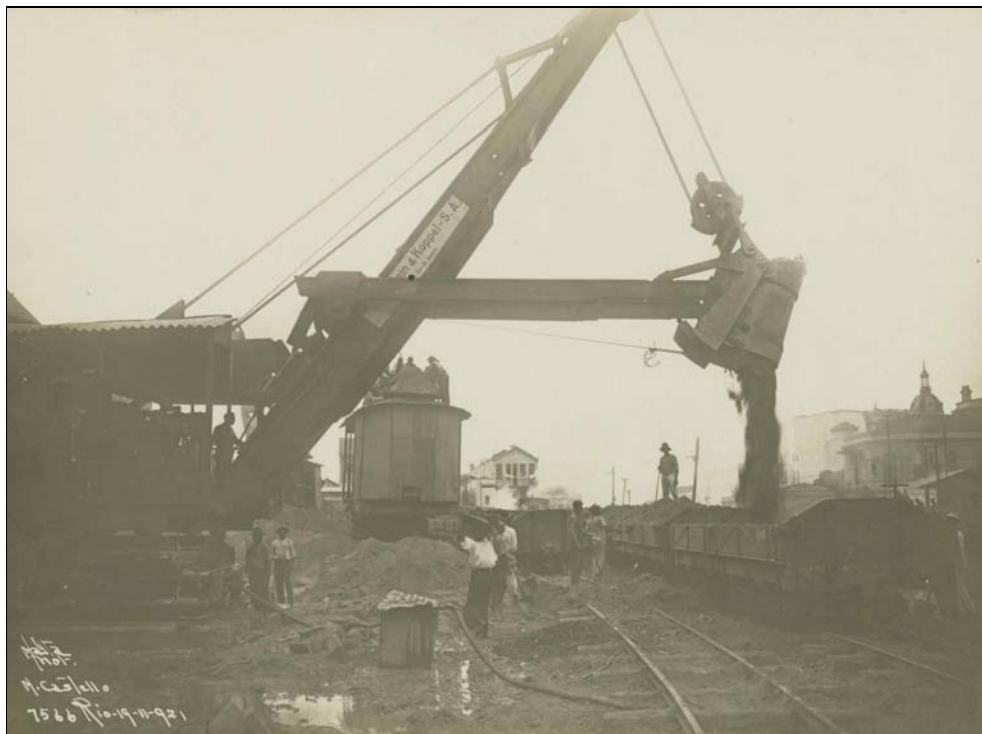
FOTO 6: Máquina empregada no desmonte do Morro do Castelo (1921)
