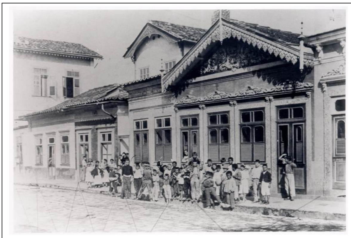
Imagem 1 - Prédio da Rua Frei Caneca.
