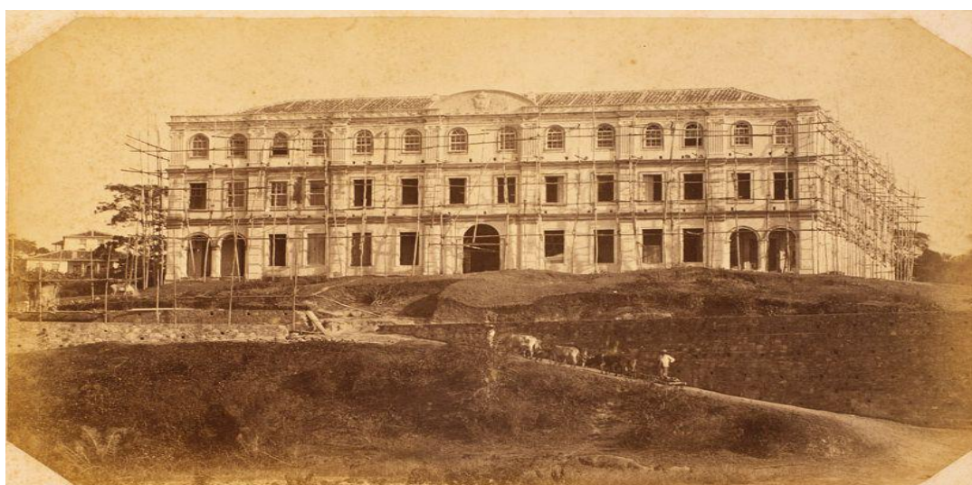
Figura 41 - Vista da construção do prédio central do Imperial Instituto de Agricultura da Bahia, onde funcionou o AA da Bahia, (s/d).
