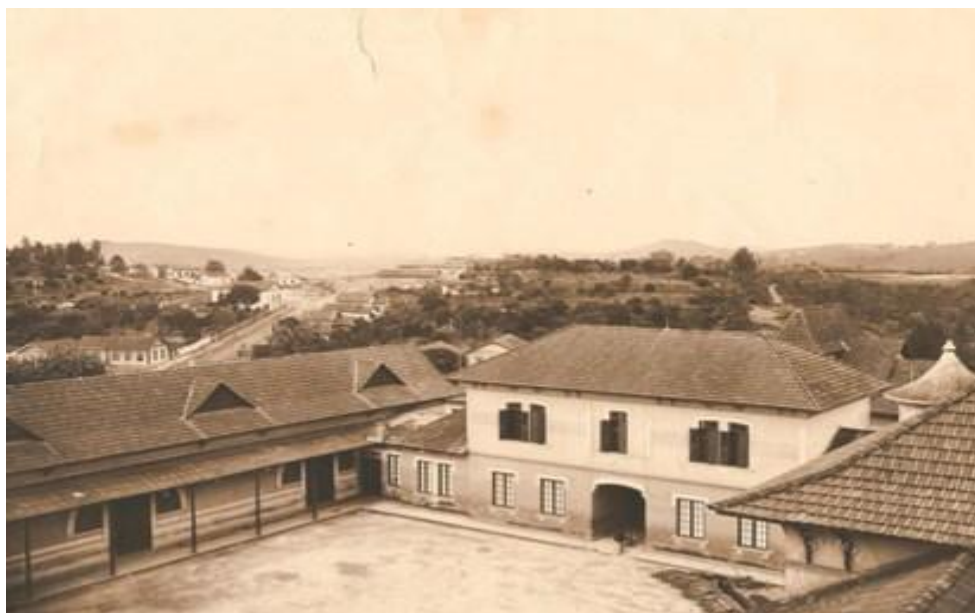
Figura 51 - Pátio interno - entrada para as Oficinas de Manufaturas e o prédio de dois andares, em que foram instaladas as Salas dos Laboratórios e do Museu de História Natural no primeiro piso e o Alojamento dos Alunos no piso superior. Fonte: Acervo da Instituição (s/d).
