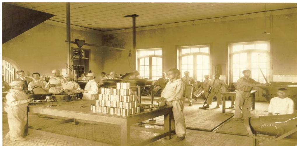
Figura 61 - Fábrica de Conservas ou Núcleo de Processamento de Vegetais, s/d.
