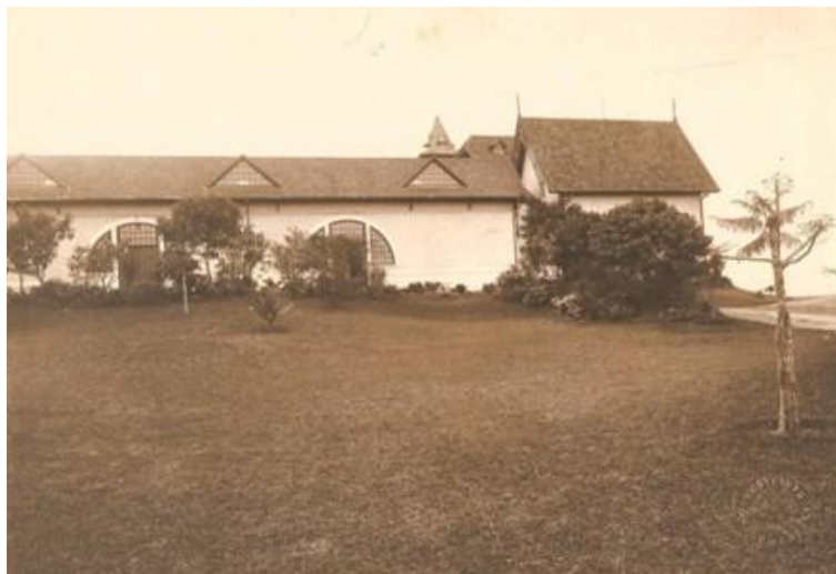
Figura 47 - Vista lateral do Setor de Jardinagem localizado em frente às Oficinas de Manufatura - Acervo da Instituição (s/d).
